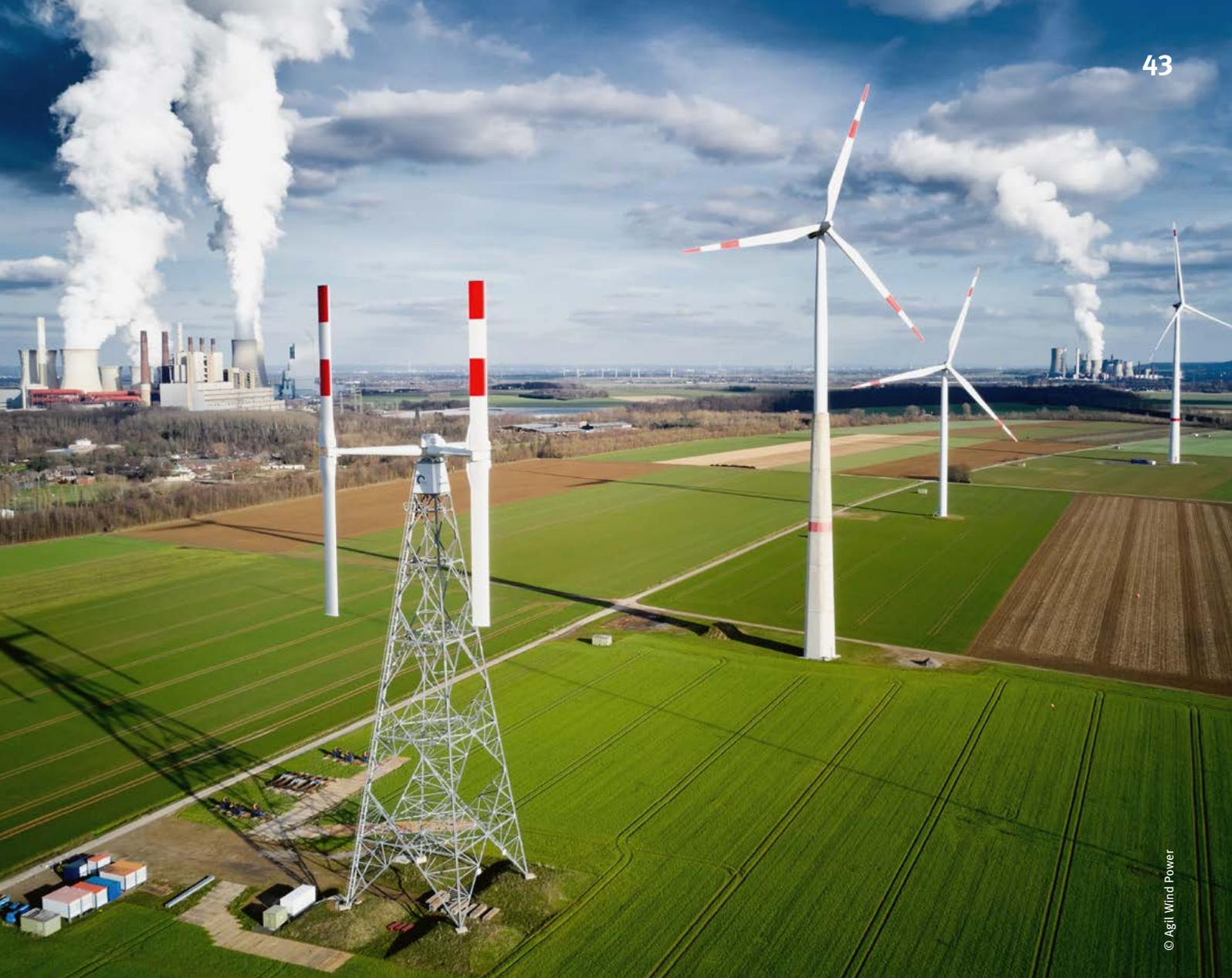
Die Windturbinen von Agile Wind Power (vorne im Bild) sind mit rund 100 Metern kleiner als konventionelle Windräder. Sie drehen sich langsamer und sind dadurch deutlich leiser.
