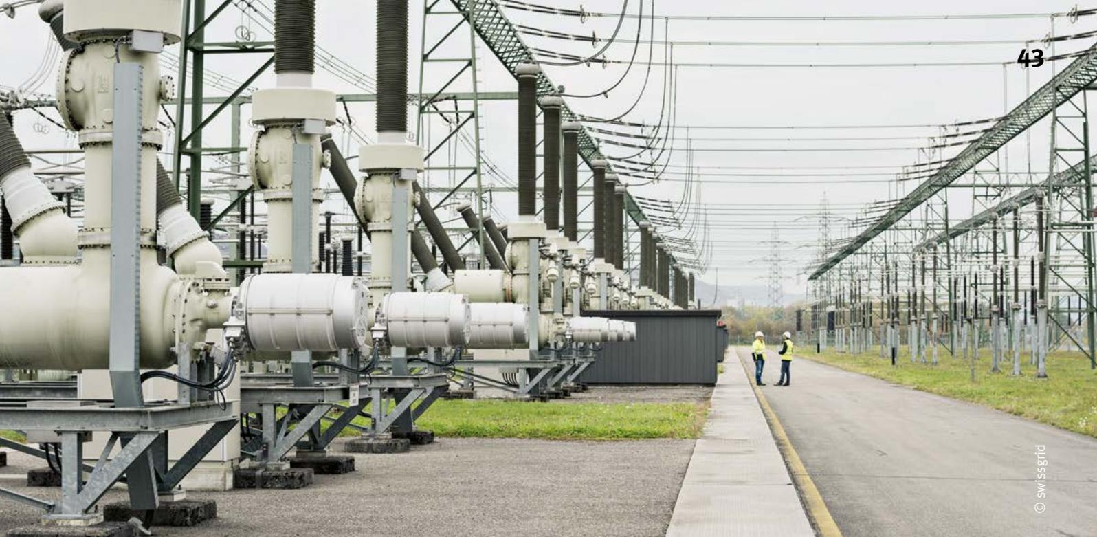
PASS (plug and switch system) Module der 380-kV-Freiluftschaltanlage in Laufenburg
