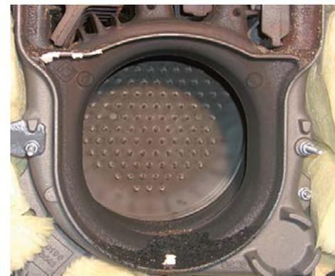
**Camera di combustione alimentata con olio combustibile ecologico a basso contenuto di zolfo di una caldaia dopo 1'800 ore di funzionamento.**
