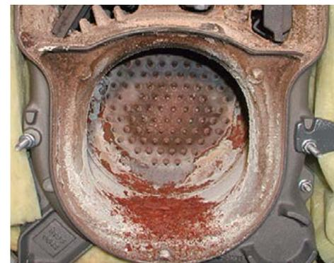
**Camera di combustione di una caldaia alimentata con olio combustibile Euro dopo 1'800 ore di funzionamento (= funzionamento medio di un impianto di riscaldamento in Svizzera in un anno)**
