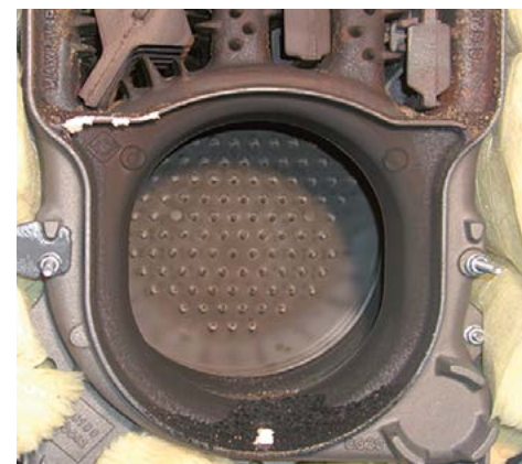
Brennkammer eines Kessels nach 1800 Stunden Laufzeit, der mit Ökoheizöl schwefelarm befeuert wird.
