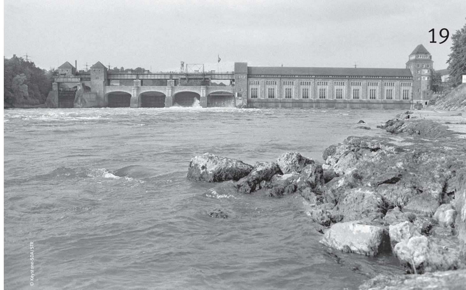
Centrale hydroélectrique sur le Rhin à Laufenburg
