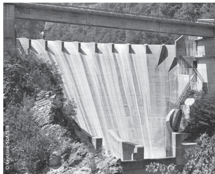
Le barrage du Lago del Palagnedra dans les Centovalli
