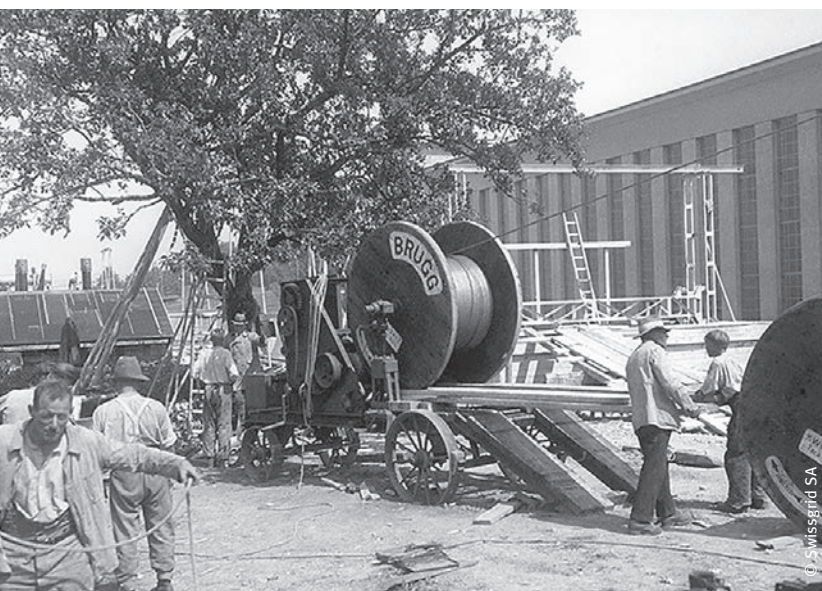
Construction de lignes électriques dans le canton d'Argovie
