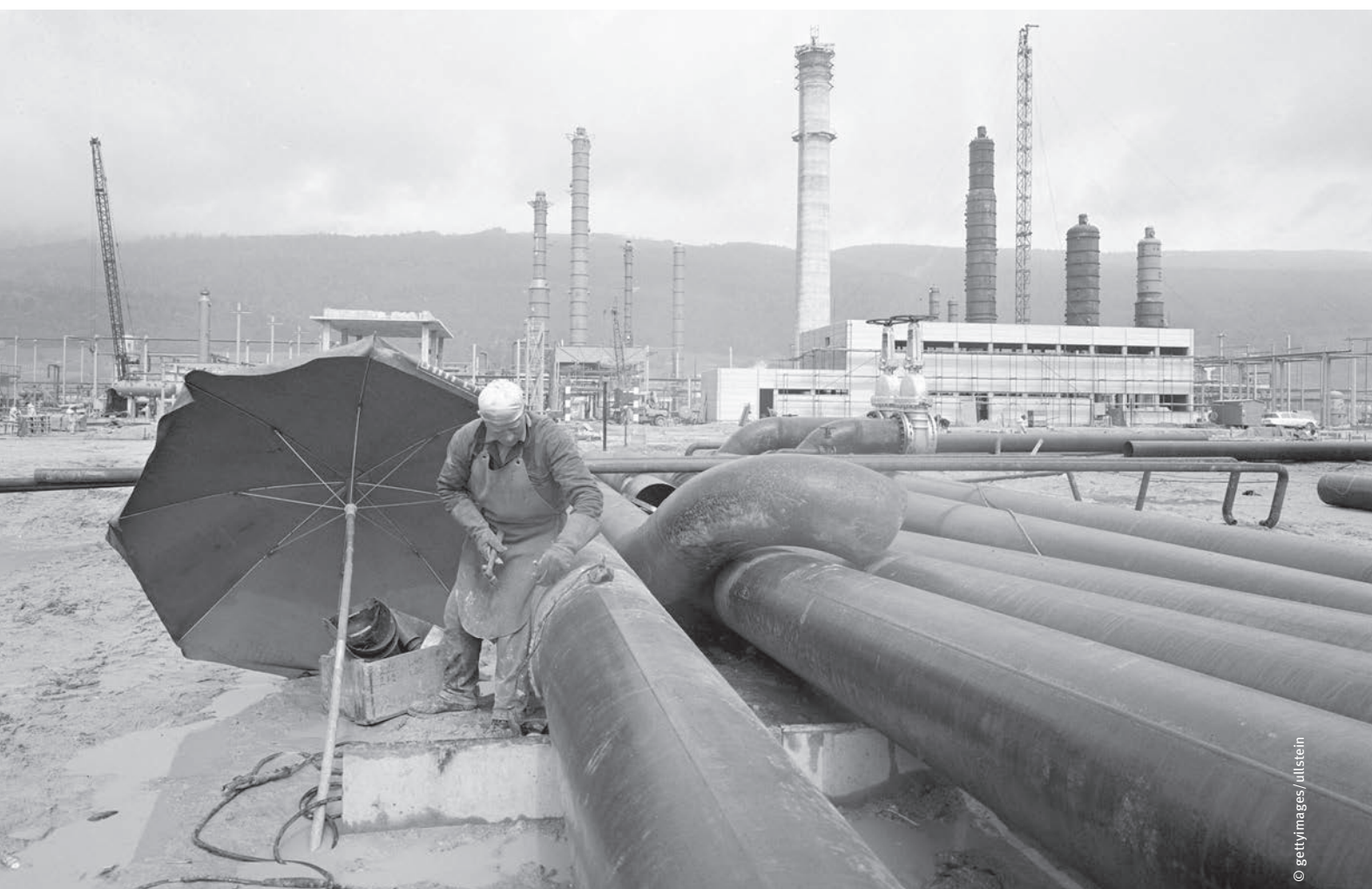
Construction de la raffinerie de Cressier.
